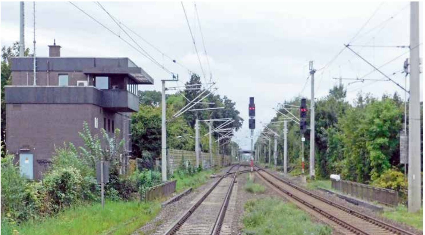
Bild 2 Rahlstedt Bahnsteig Südende: Die Entfernung vom Standort bis zur Brücke im Hintergrund beträgt 560 Meter
