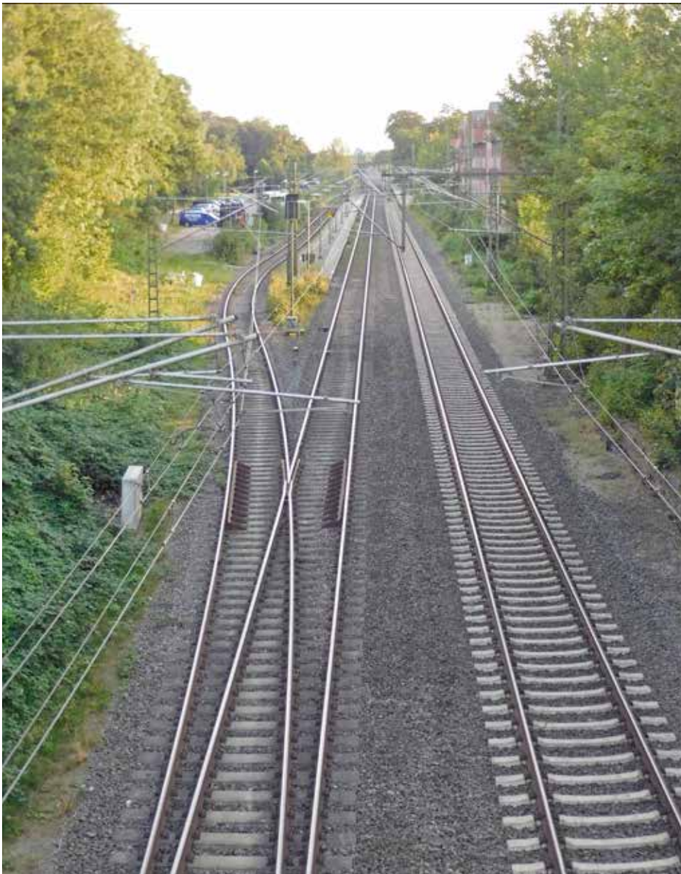
Bild 10 Nordseite des Bahnhofs, ganz links ist der neue S-Bahn-Seitenbahnsteig geplant
