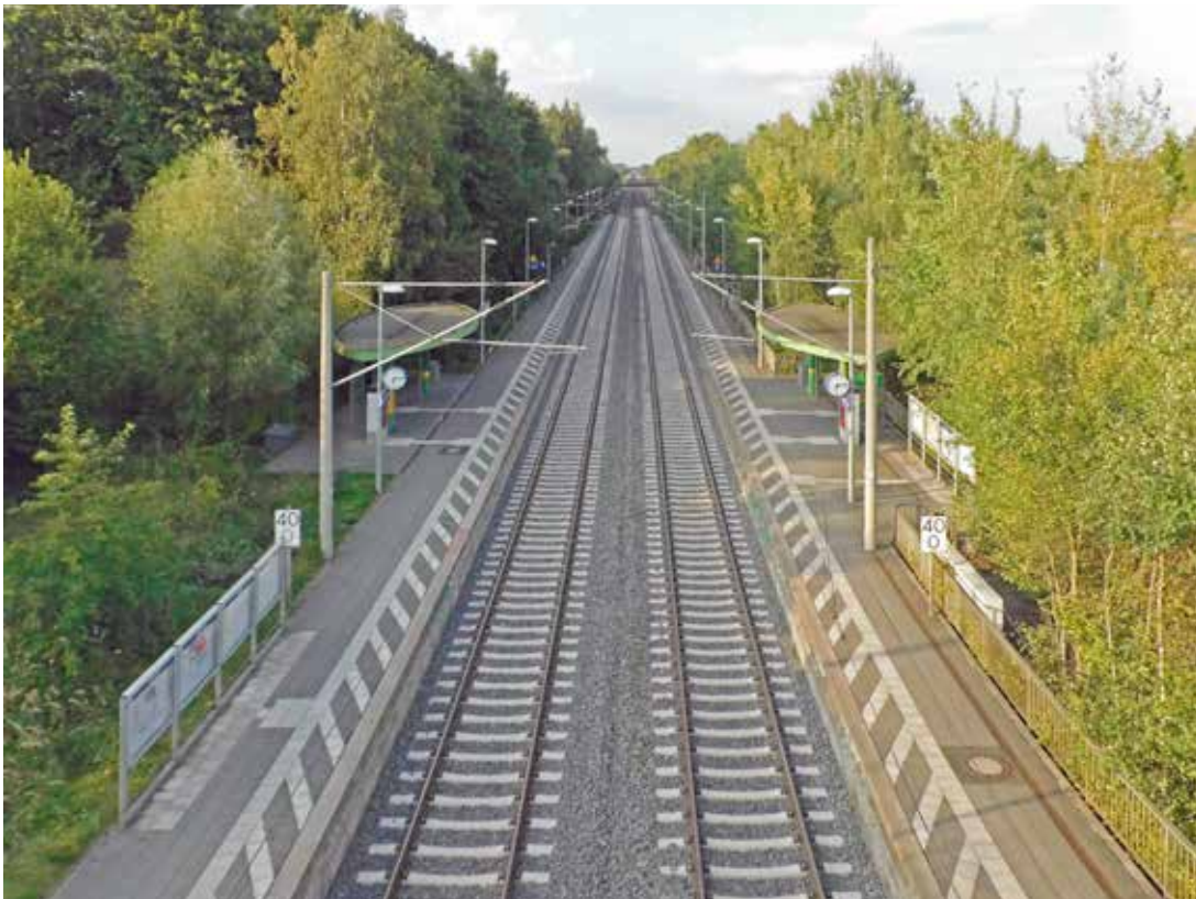
Bild 6 Haltepunkt Ahrensburg-Gartenholz mit Seitenbahnsteigen
