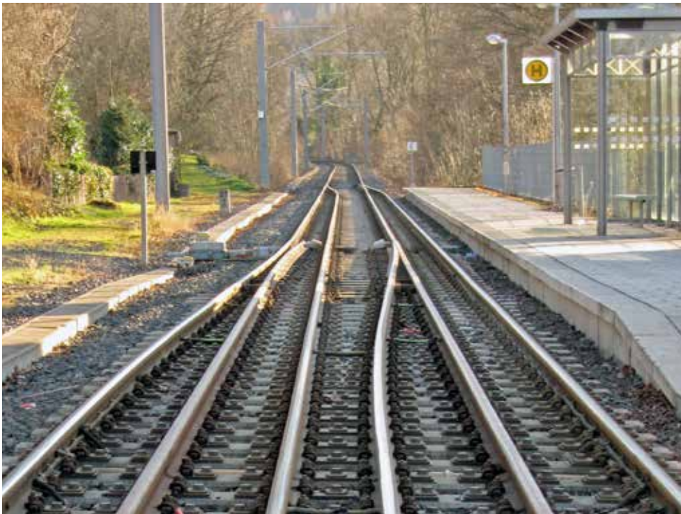
Bild 9 Gleisverschlingung zum Heranführen von Personenzügen an Bahnsteige
