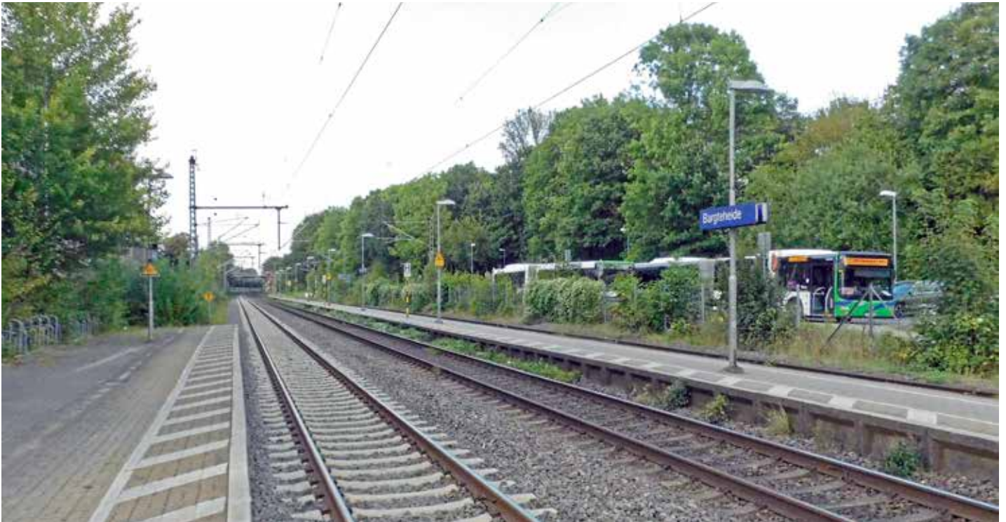
Bild 7 Bahnhof Bargteheide: Links der Hausbahnsteig und rechts der nur vier Meter breite Mittelbahnsteig mit zwei Gleisen
